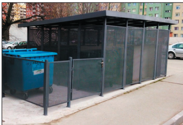
Nowa osłona śmietnikowa przy ul. Drzewieckiego.
