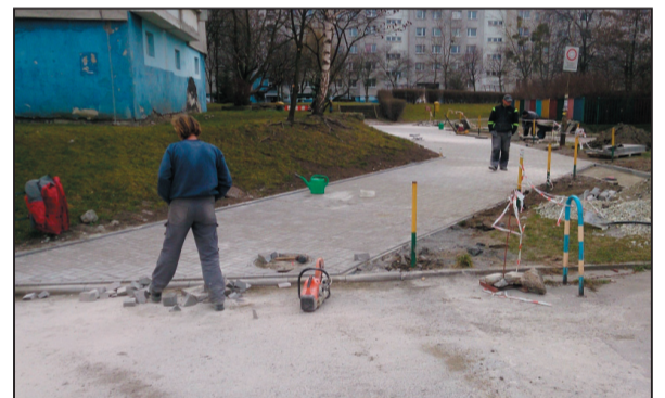
Ciąg pieszo-jezdny przy ul. Horbaczewskiego i Bajana.
