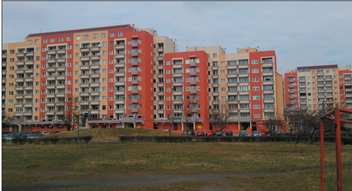
Budynki po termomodernizacji przy Bulwarze Ikara
